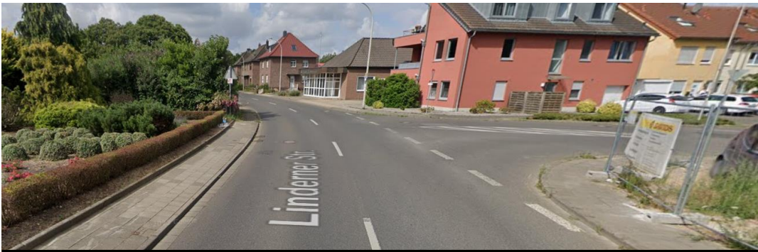
Ortseingang Würm Radweg auf der Straße, Schutzstreifen ca. 1,25 m
